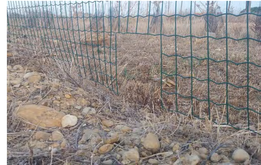
Exemple d'aménagement réalisé dans une clôture et permettant le passage de la petite faune.
