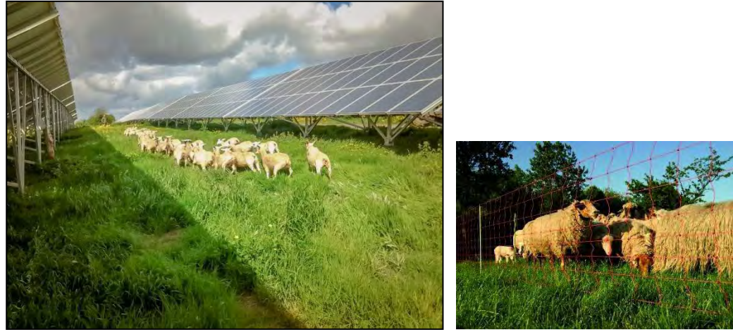
Exemple d'une centrale photovoltaïque au sol entretenue par pâturage et de filet mobile pour moutons (©Gallagher)
